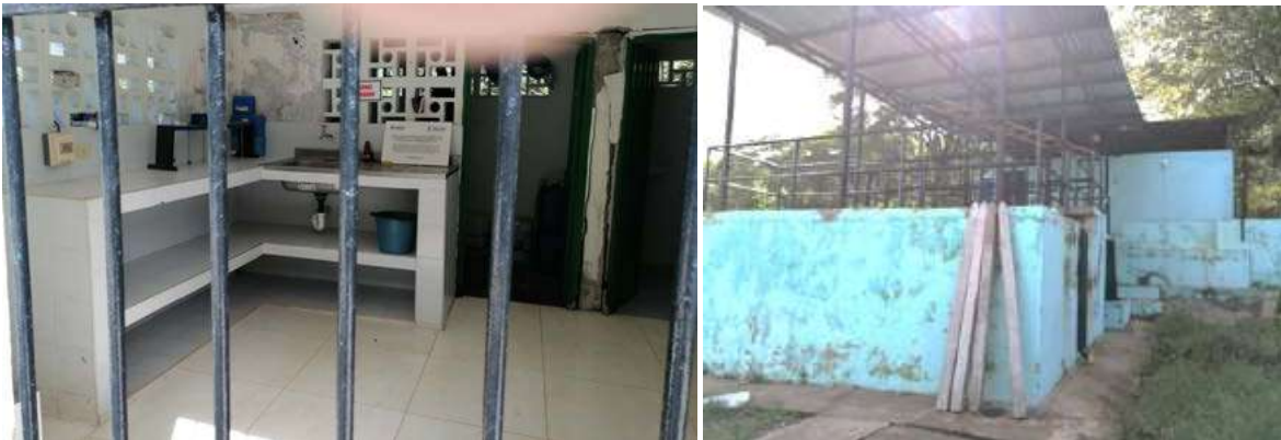
Imagen 46. Laboratorio y estado actual de la infraestructura de la PTAP de Santiago Pérez
