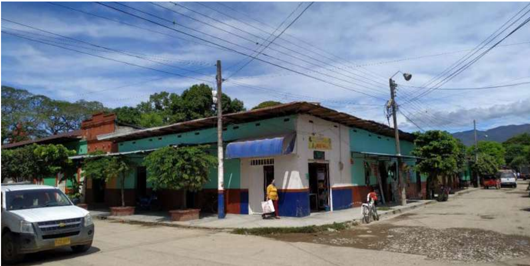
Imagen 20. Ejemplo de Tipología de vivienda unifamiliar de uso mixto, de un (1) piso
