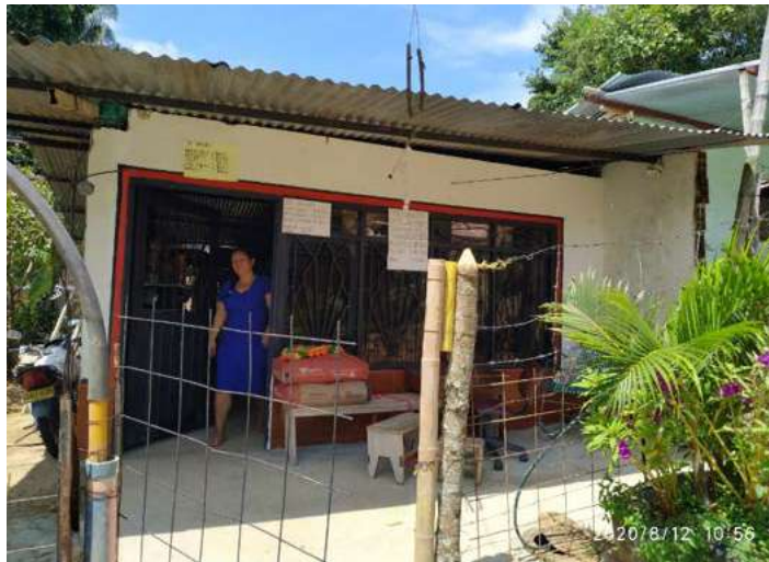
Imagen 35. Vivienda unifamiliar Asentamiento ubicado en la calle 8 entre cra 1 y cra 1a
