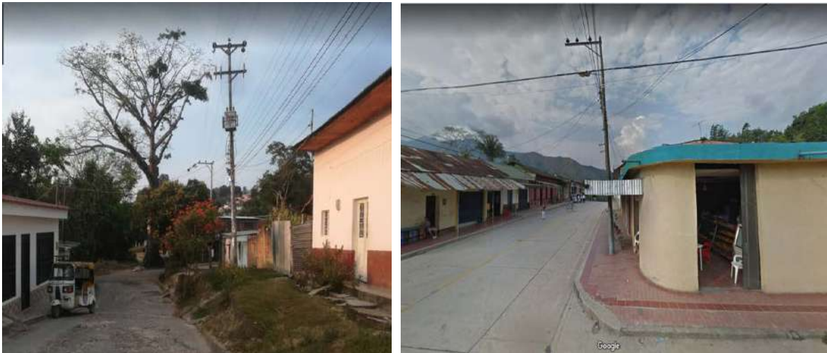
Gráfico 161. Municipio de Rovira. Infraestructura de interconexión eléctrica instalada en la cabecera municipal
