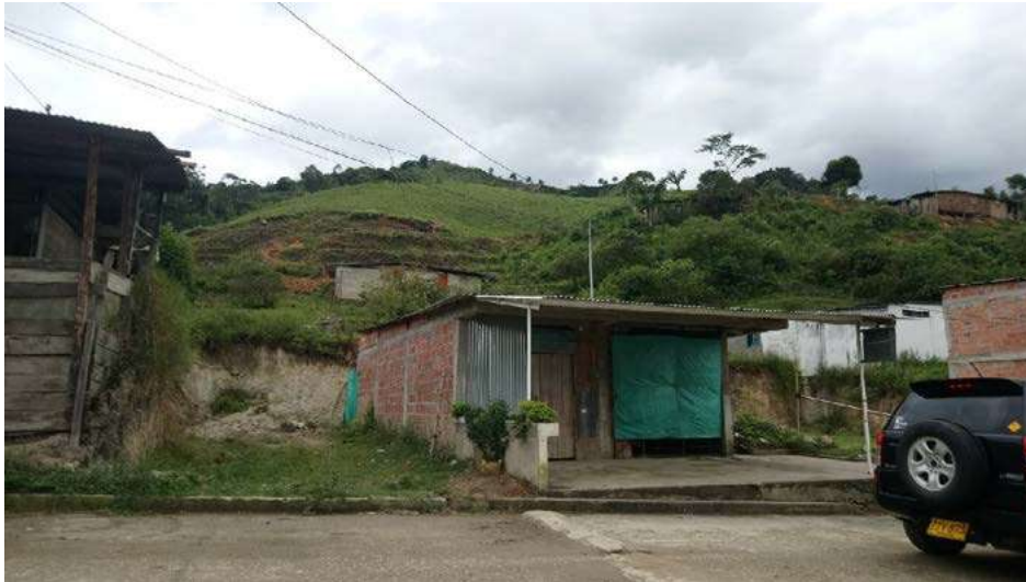
Gráfico 207. Municipio de Rioblanco. Punto en condición de riesgo por movimientos en masa en centro poblado Herrera, localizado en coordenadas -75,816602 E y 3,289269 N
