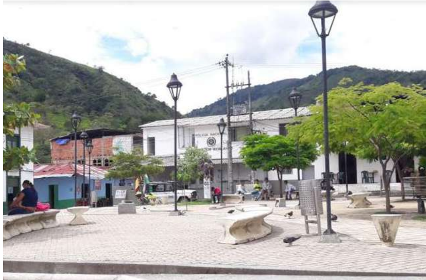
Gráfico 240. Municipio de Rioblanco. infraestructura de alumbrado público existente en la cabecera municipal
