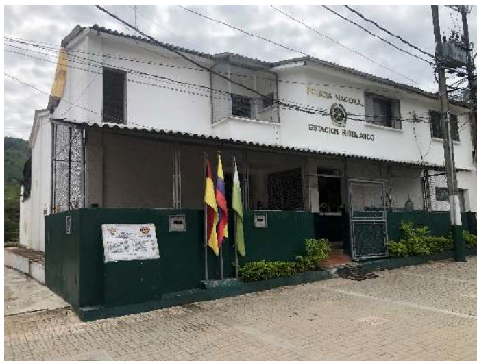
Gráfico 69. Municipio de Rioblanco. Vista de la fachada de la Estación de Policía ubicada en la cabecera municipal
