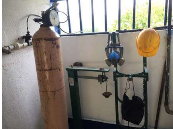
Gráfico 223. Municipio de Rioblanco. Dispensador de cloro de la PTAP de la cabecera municipal
