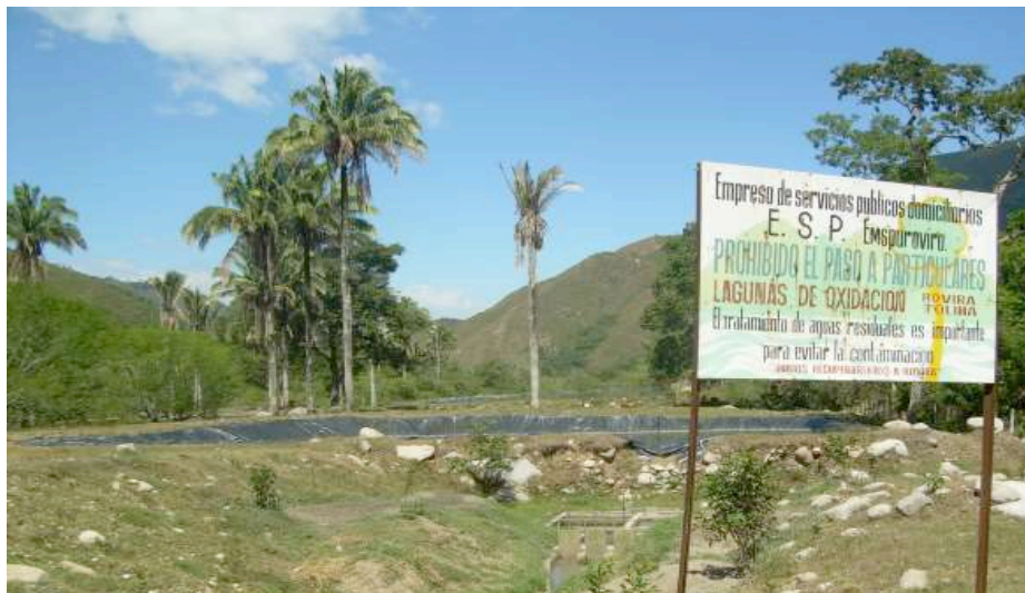
Gráfico 150. Municipio de Rovira. Señalización del predio donde se localiza la Planta de Tratamiento de Aguas Residuales de la Cabecera Municipal
