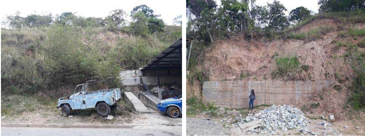
Gráfico 197. Municipio de Rioblanco. Puntos con condición de riesgo por movimientos en masa en la Cabecera Municipal localizados en las coordenadas -75,642812 E y 3,529691 N
