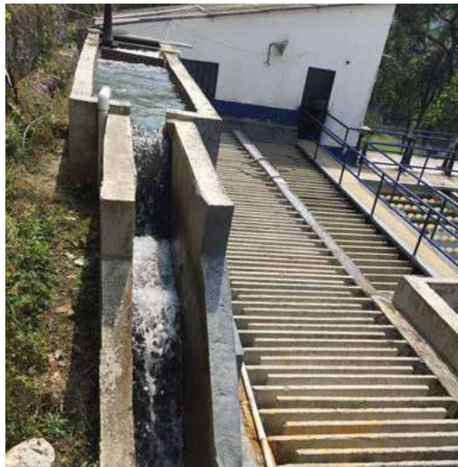
Gráfico 220. Municipio de Rioblanco. Floculador de la planta de tratamiento de agua potable de la cabecera municipal
