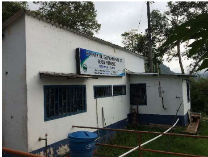
Gráfico 216. Municipio de Rioblanco. Vista de la planta de tratamiento de agua potable del acueducto de la cabecera municipal
