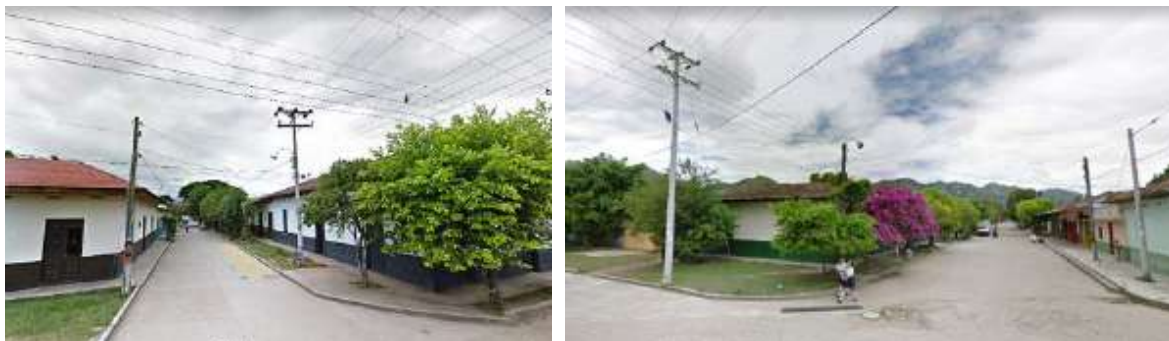
Imagen 50. Infraestructura eléctrica instalada Zona Residencial.
