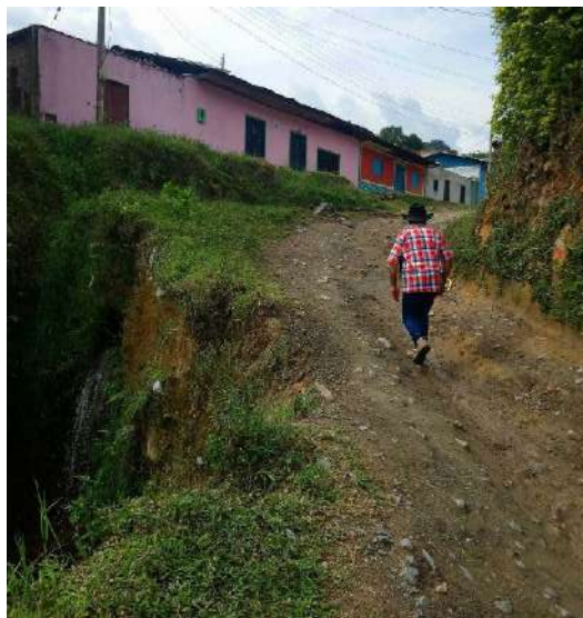
Gráfico 208. Municipio de Rioblanco. Punto en condición de riesgo por movimientos en masa en centro poblado Herrera, localizado en coordenadas -75,821023 E y 3,284707 N
