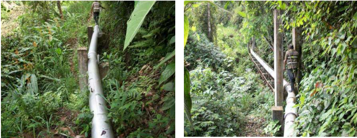
Gráfico 139. Municipio de Rovira. Líneas de conducción del acueducto de la cabecera municipal
