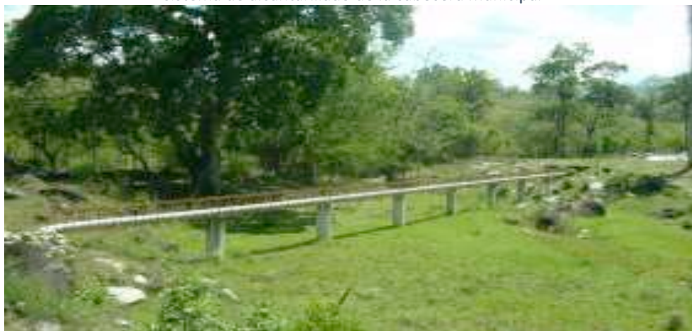
Gráfico 154. Municipio de Rovira. Viaducto de conducción de aguas residuales entre las lagunas de oxidación del sistema de alcantarillado de la cabecera municipal
