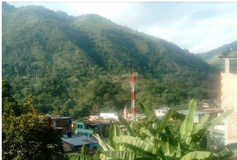
Gráfico 247. Municipio de Rioblanco. Antena de telecomunicaciones ubicada en la cabecera municipal
