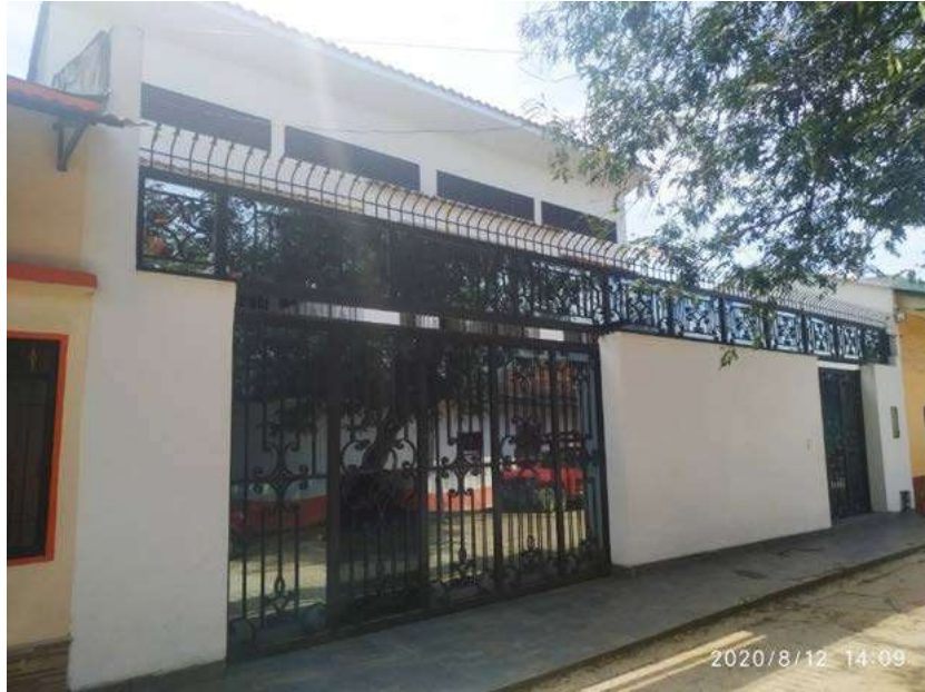
Imagen 21. Ejemplo de Vivienda Unifamiliar Tipo Casona. Municipio de Rovira
