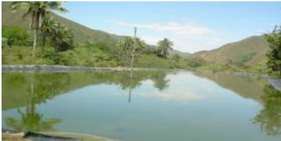
Gráfico 153. Segunda laguna de oxidación (facultativa) sistema de alcantarillado de cabecera
