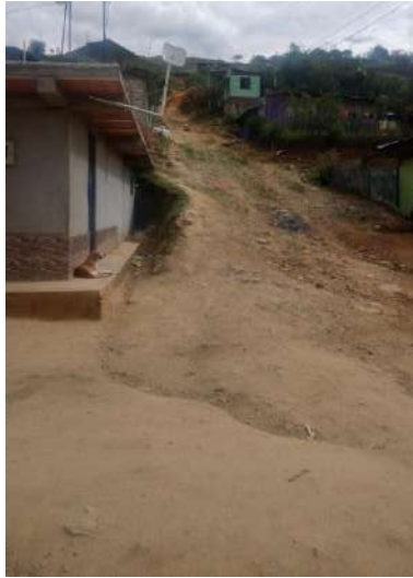
Gráfico 209. Municipio de Rioblanco. Punto en condición de riesgo por movimientos en masa en centro poblado Herrera, localizado en coordenadas -75,742576 E y 3,577163 N
