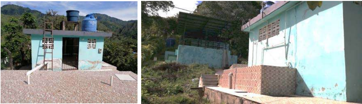
Imagen 45. Planta de tratamiento Santiago Pérez
