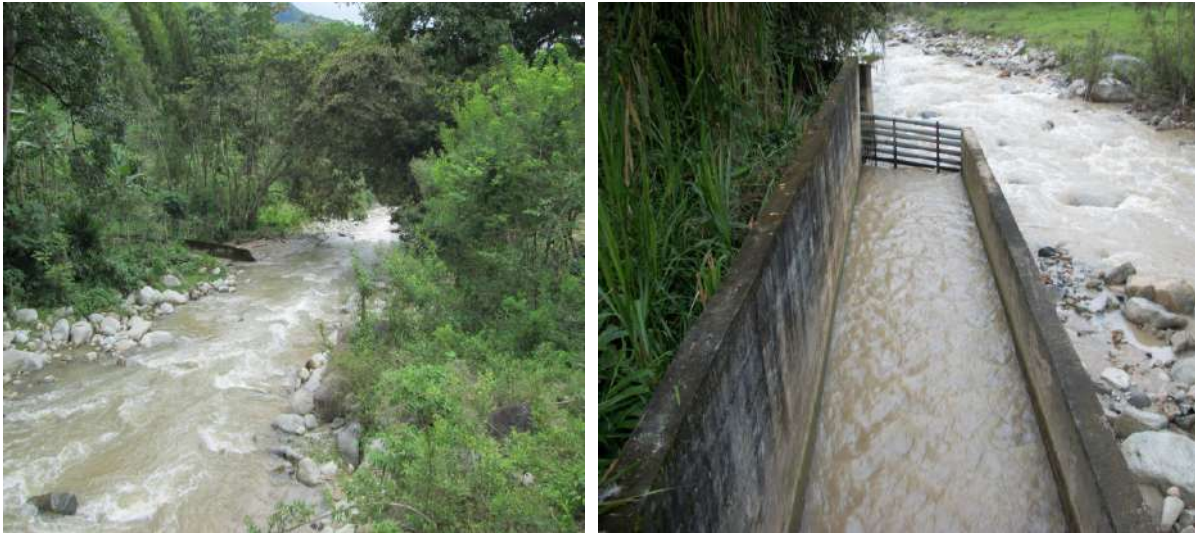
Gráfico 135. Municipio de Rovira. Captación del acueducto de la cabecera municipal sobre el río Luisa
