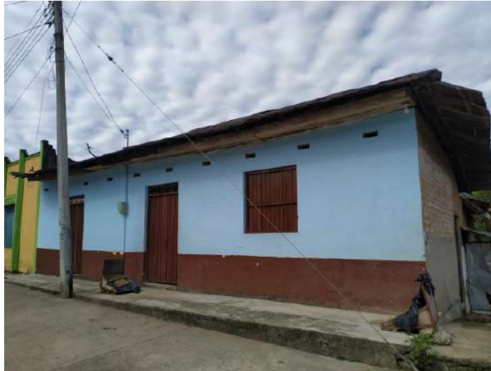
Gráfico 86. Municipio de Rioblanco. Vivienda bifamiliar tradicional en barrio Centro de la cabecera municipal
