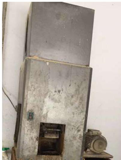
Gráfico 219. Municipio de Rioblanco. Dosificador de sulfato de la planta de tratamiento de agua potable de la cabecera municipal
